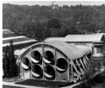
En 1935, les essais en soufflerie se généralisent. En Angleterre, au Royal Aircraft Establishment, à Farnborough, une soufflerie aérodynamique géante vient d'être inaugurée. Cette installation va permettre de tester tous les modèles d'avions avant leur mise en service. Analyser le comportement aérodynamique des avions dans leurs différentes configurations de vol.
